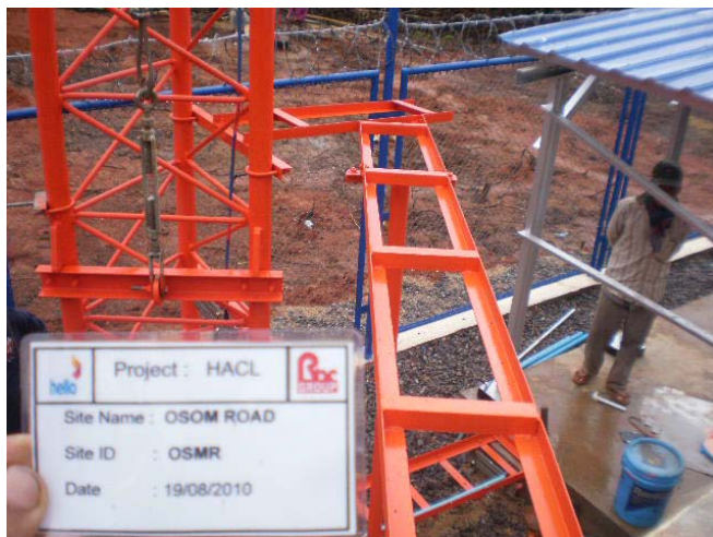
Out Door Ladder
